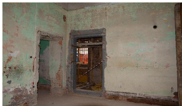
Realizzazione vespai, apertura nuove porte prove di carico della soletta (edificio che si affaccia su Via Litta)
