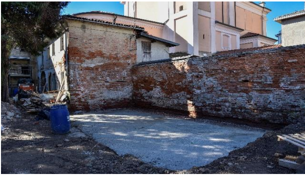
Abbattimento vecchi ruderi: lavoro di "cucitura" e rafforzamento recinzione ed edificio adiacente Realizzazione di nuovo spazio per laboratorio
