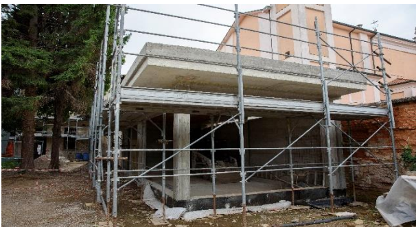
Abbattimento vecchi ruderi: lavoro di "cucitura" e rafforzamento recinzione ed edificio adiacente Realizzazione di nuovo spazio per laboratorio
