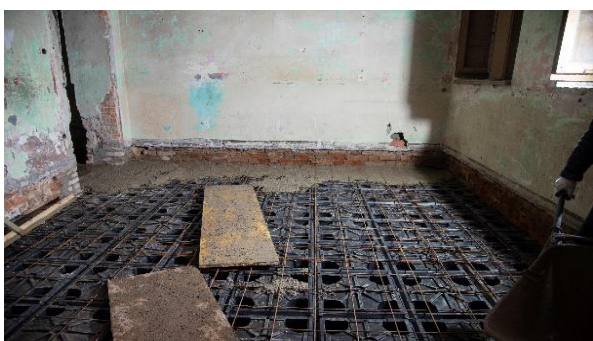
Realizzazione vespai, apertura nuove porte prove di carico della soletta (edificio che si affaccia su Via Litta)
