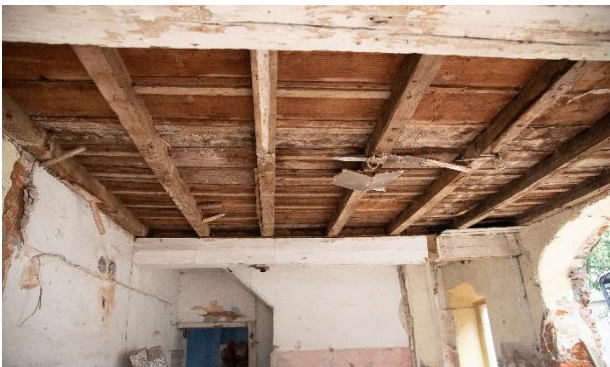
Edificio interno: soletta in legno gravemente deteriorata e pericolante; abbattimento per nuova realizzazione
