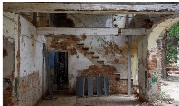
Edificio interno: soletta in legno gravemente deteriorata e pericolante; abbattimento per nuova realizzazione
